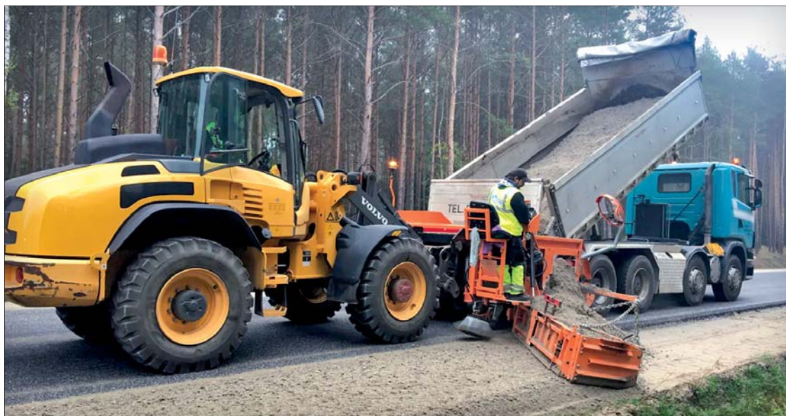
Strassmayr nabízí také různé varianty tažených a tlačných (foto) zakladačů a rozšiřovačů krajnic modelové řady BF
