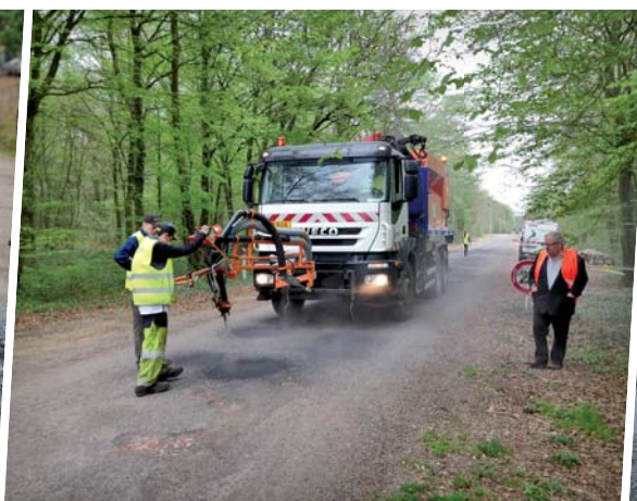
Vysprávkové soupravy STP mohou mít zadní nebo čelní aplikační rameno (foto) ovládané joystickem nebo na dálku radiem
