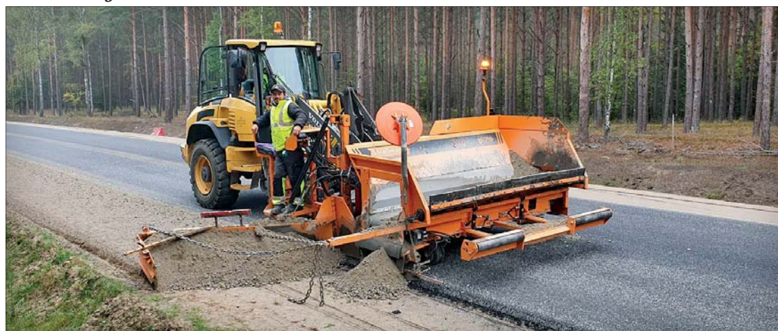
Strassmayr nabízí také různé varianty tažených a tlačných (foto) zakladačů a rozšiřovačů krajnic modelové řady BF
